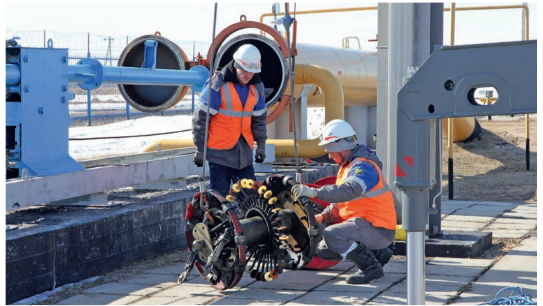
Сотрудники Юргинского ЛПУМГ запускают внутритрубное устройство для проведения диагностики
