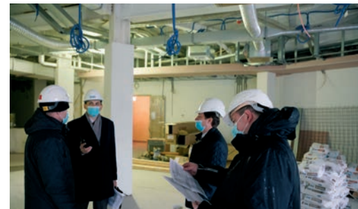
Строительство «Кедрового» вошло в завершающую стадию: ведутся внутренние отделочные работы
