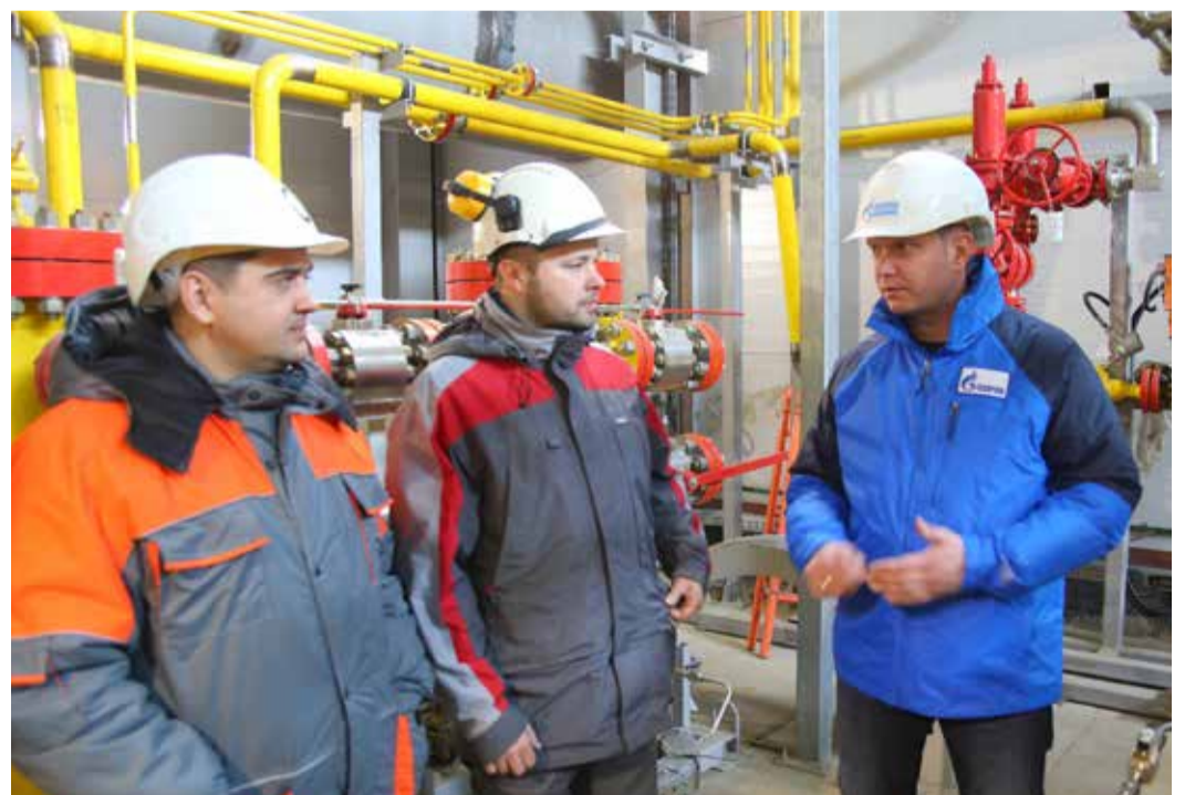
Оперативное совещание заказчика и подрядчика строительства компрессорной станции
