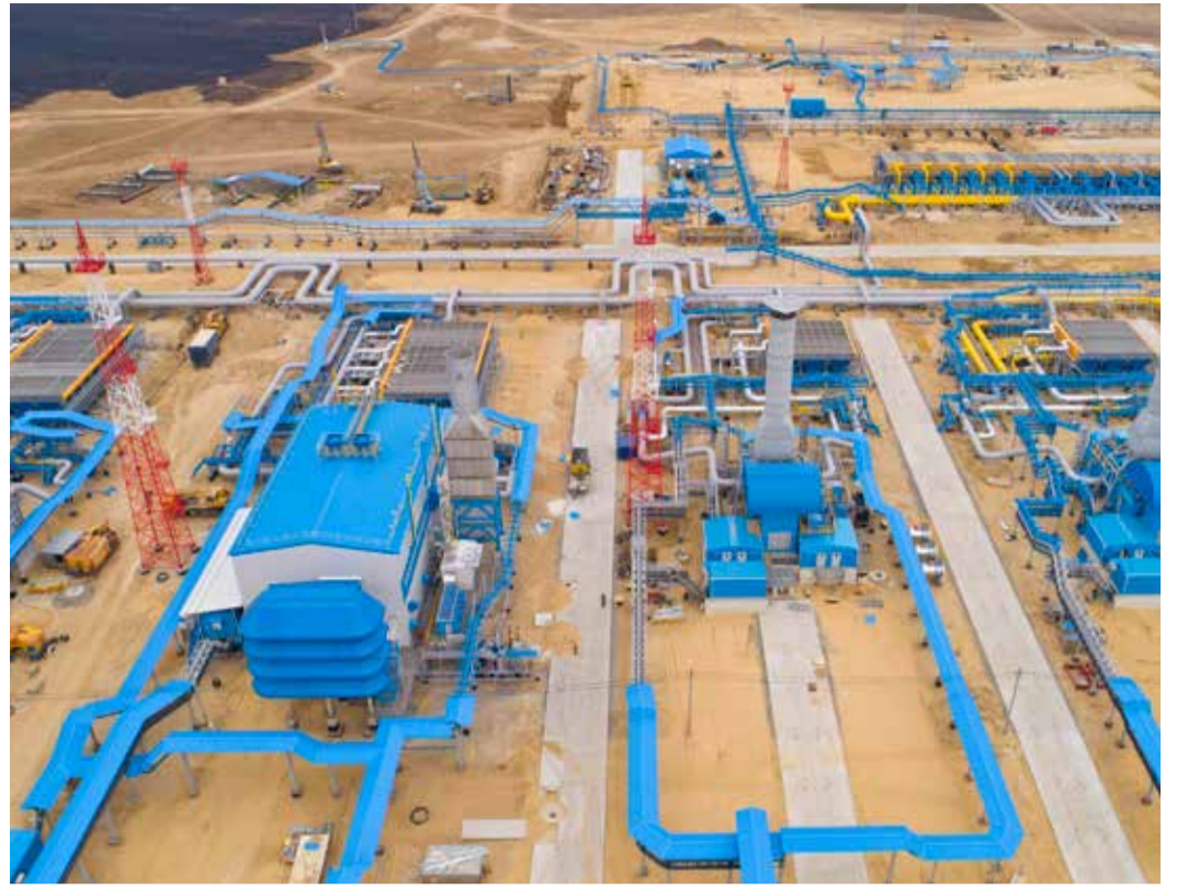
На КС 7а «Зейская» ведутся пусконаладочные работы
