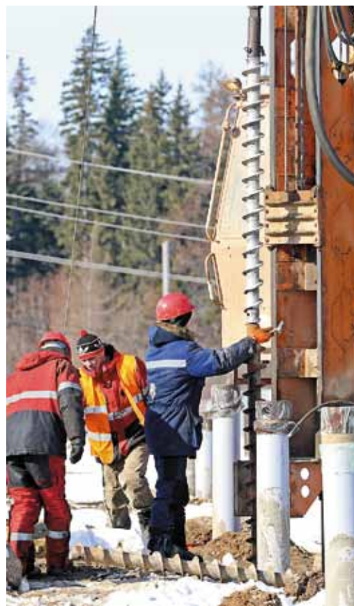
Работа сваебойной машины под контролем специалистов
