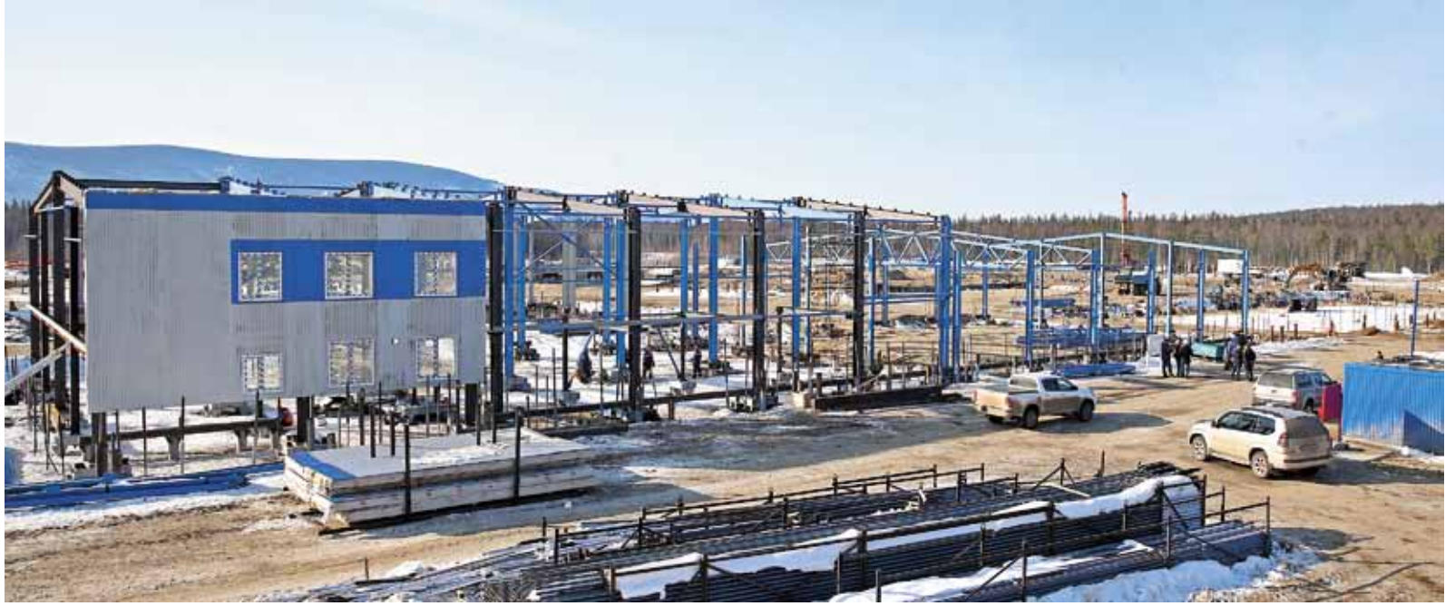
Идет активная работа по возведению производственной базы Ленского ЛПУМГ
