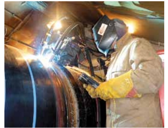
Сварка заполняющих слоёв
