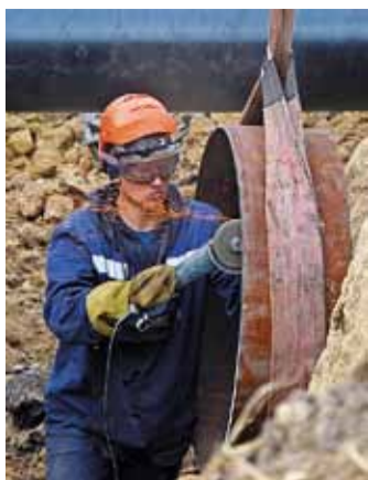
Подготовка шва к сварке
