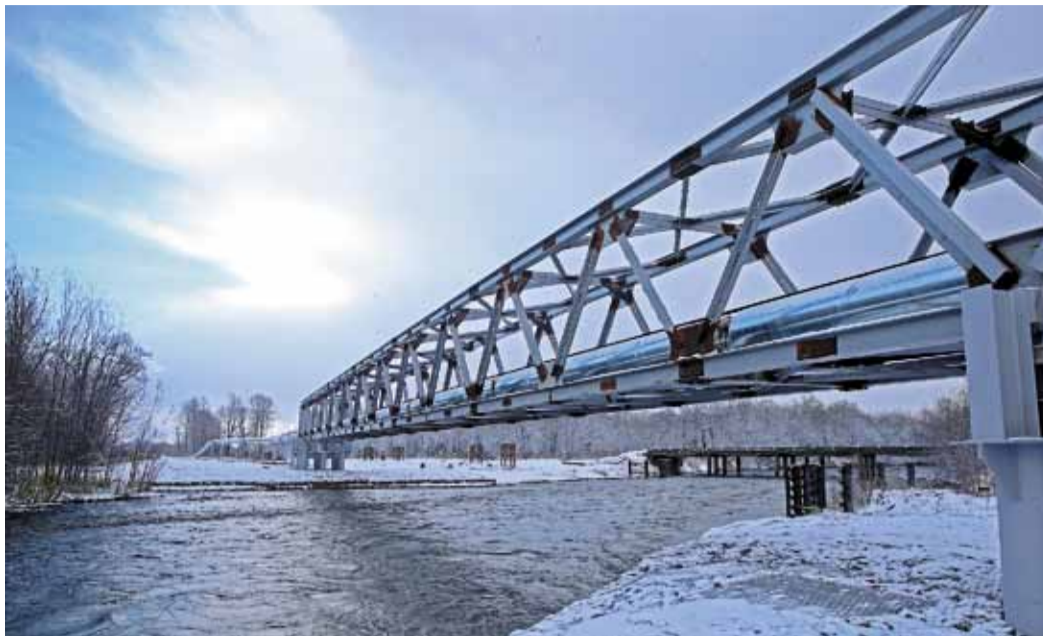
Балочные переходы — надежная конструкция для магистрального газопровода
