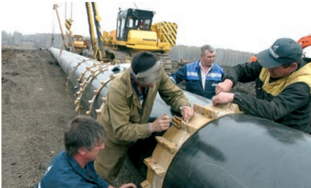
↓ Подготовка трубы к укладке
