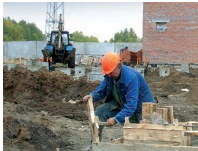
↓ Строительство нового здания компрессорного цеха
