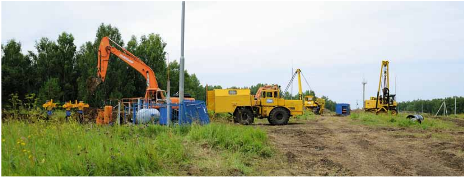
Одна из площадок, где проводится ремонт газопровода. Несмотря на кажущуюся статичность, работа кипит
