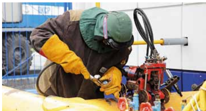
Ремонтные работы на ГРС-3 Томска
