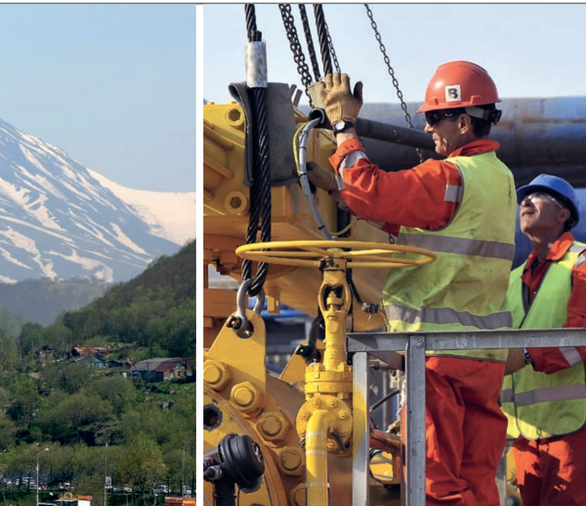
↑ Монтаж камеры запуска скребка «поршня» на ОБТК компании «Сахалин Энерджи»
