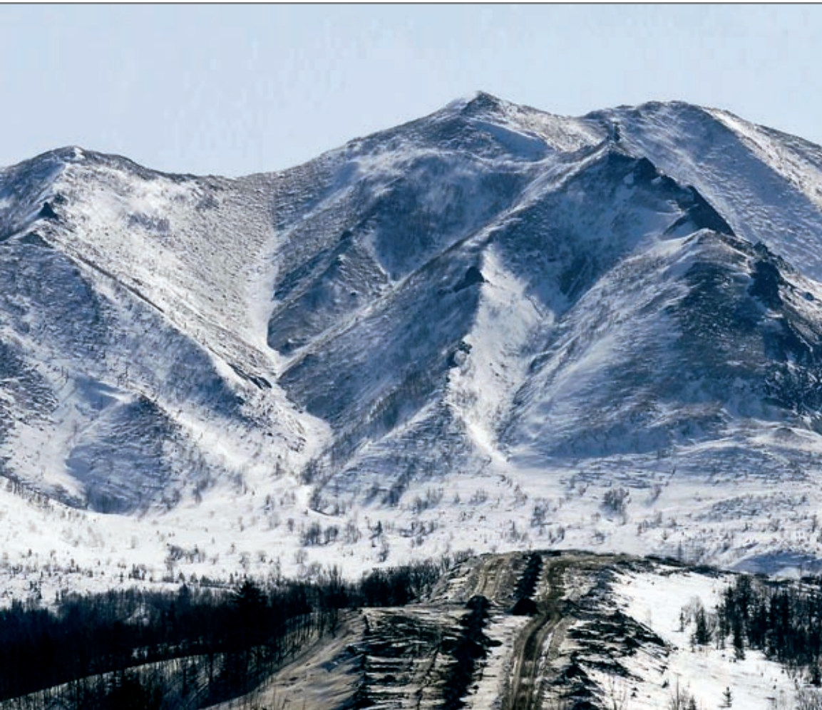
↑ Транссахалинская трубопроводная система - один из самых сложных проектов в мире. Фото предоставлено «Сахалин Энерджи»
