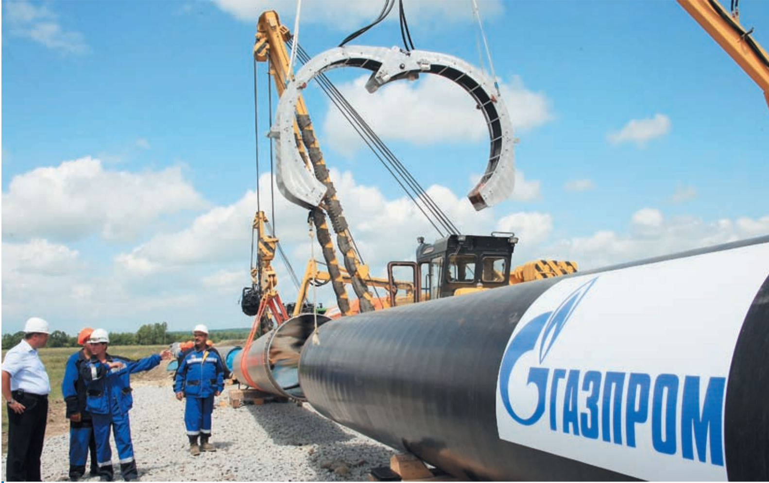
Строительство магистрального газопровода «Сахалин - Хабаровск - Владивосток»
