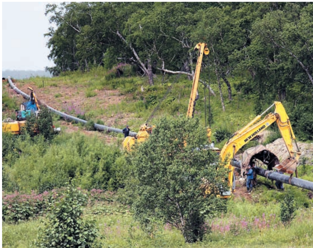
Строительство магистрального газопровода «Соболево – Петропавловск-Камчатский»
