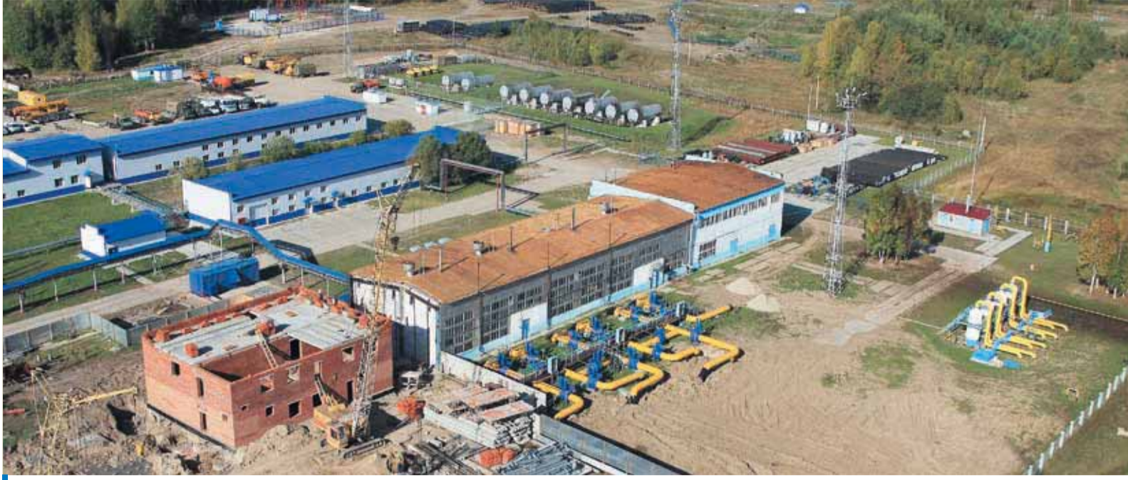
Строительство КС "Парабель". Август 2009 года
