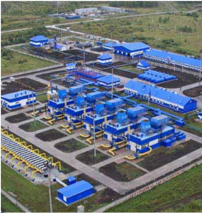
Компрессорная станция "Кожурлинская". Ремонт коснулся практически всех производственных зданий и сооружений. Сентябрь 2009 года
