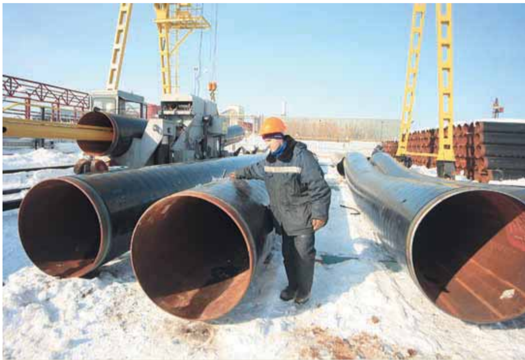
В распоряжении ТУАВР 150 машин – трубоукладчики, экскаваторы, бульдозеры, тягачи, вездеходы. Есть и установка для изгибания трубы
