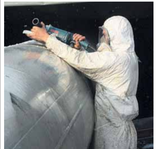
Идет процесс устранения дефектов покрытия
