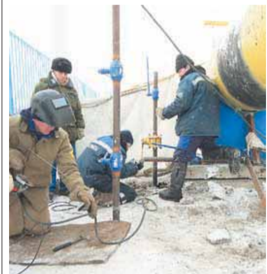
Ведется замена арматуры подключения к метанольной установке
