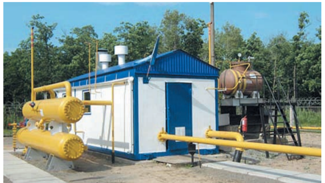
Станции приводятся в соответствие с фирменным стилем компании. Непосредственно работы ведутся на самих ГРС и операторных
