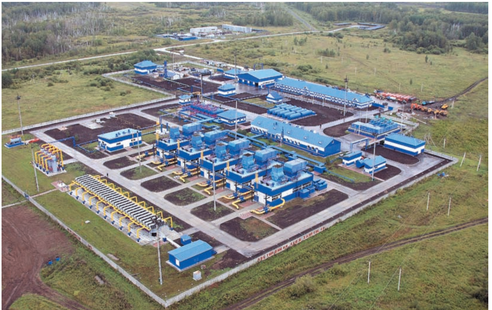
Компрессорная станция «Кожурлинская» – современный, модернизированный объект в общей системе Газпрома. Ремонт коснулся практически всех производственных зданий и сооружений
