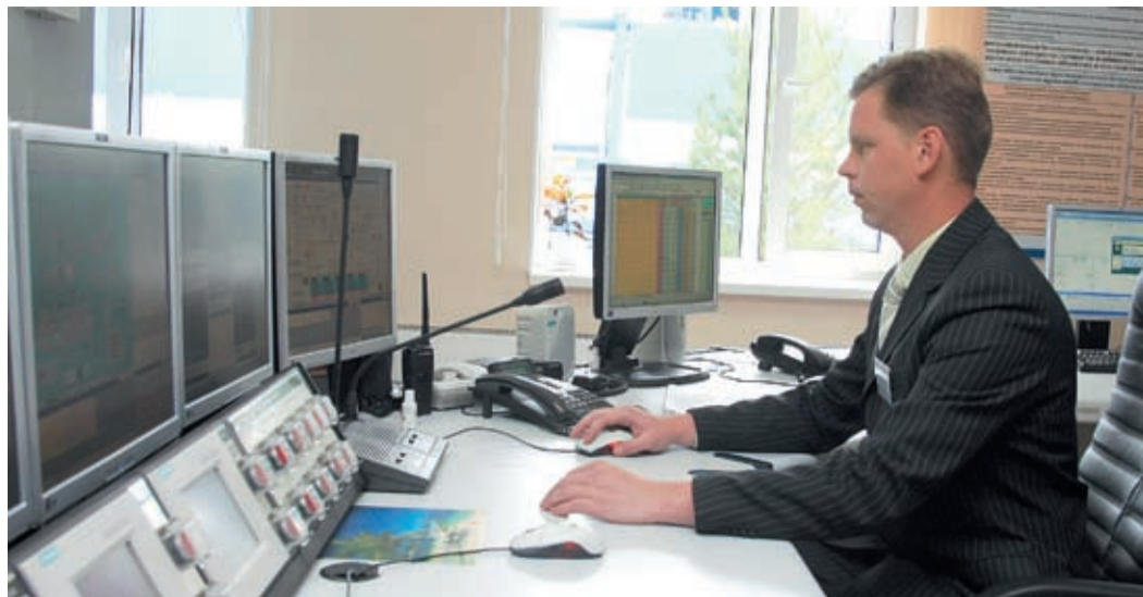
Диспетчерская КС «Кожурлинская» связана незримыми нитями с центральной диспетчерской Общества. Современные системы телемеханики позволяют управлять объектами линейной части газопровода, эксплуатируемыми Барабинским ЛПУ МГ, не только из этой диспетчерской, но и из Томска
