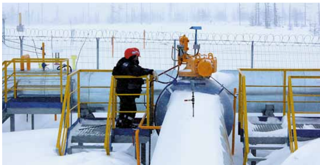
Работники Сахалинского ЛПУМТ на обслуживании газопровода
