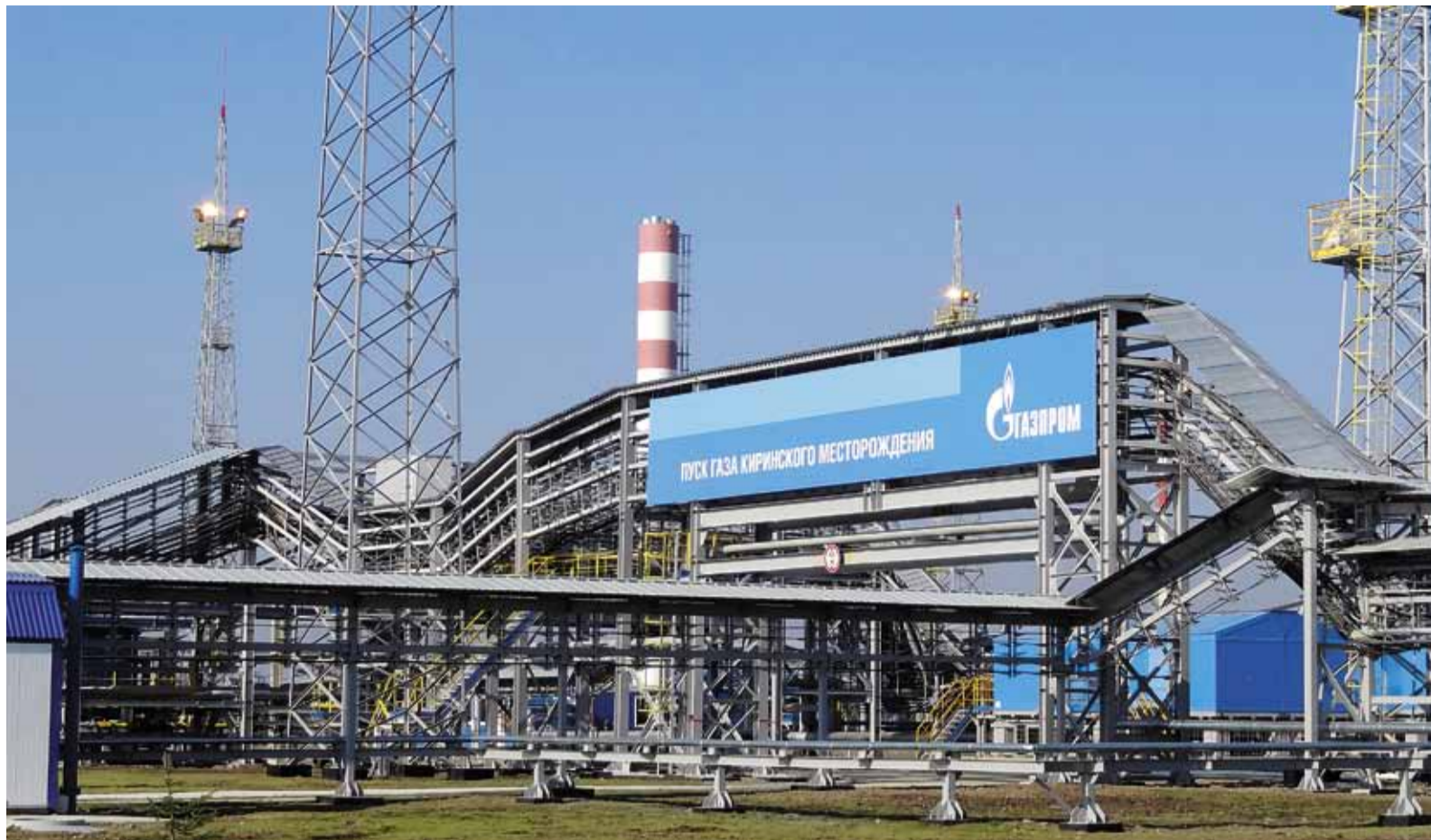
Новый объект Газпрома на Сахалине
