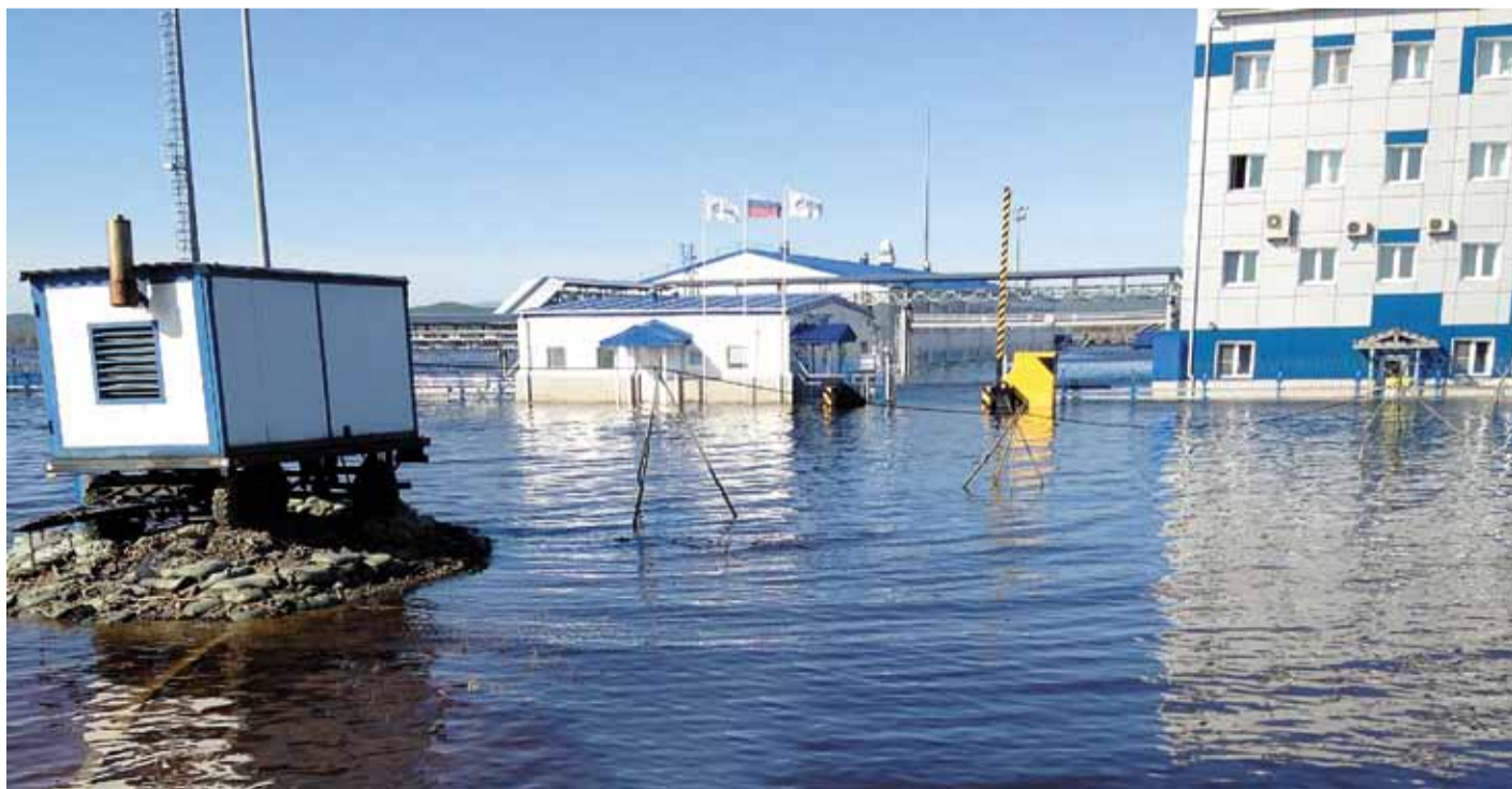
Резервное электрообеспечение АБК осуществлялось через эту дизельную электростанцию
