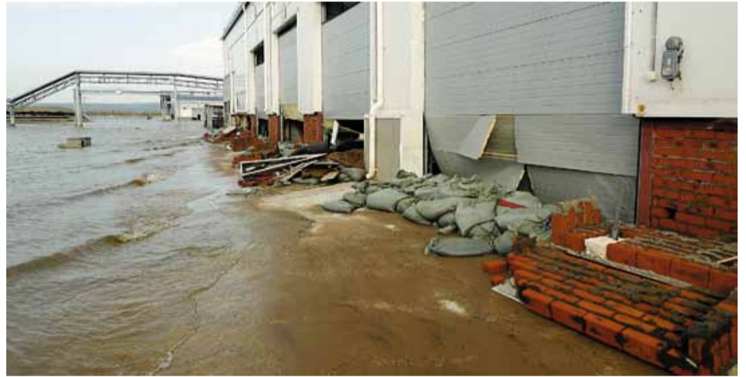
Строители одними из первых определили необходимый для восстановления базы фронт работ
