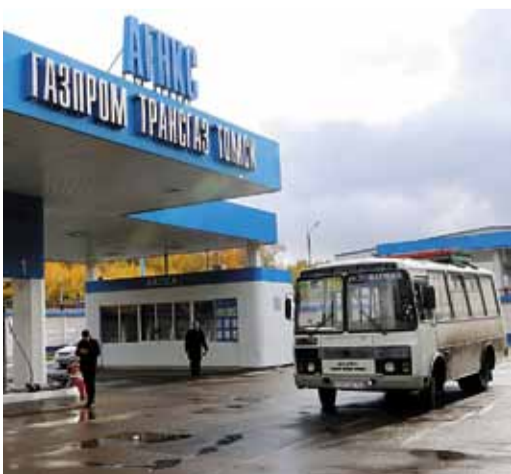
АГНКС «Газпром трансгаз Томск» – образец современного подхода к обслуживанию автомобилей на ГМТ
