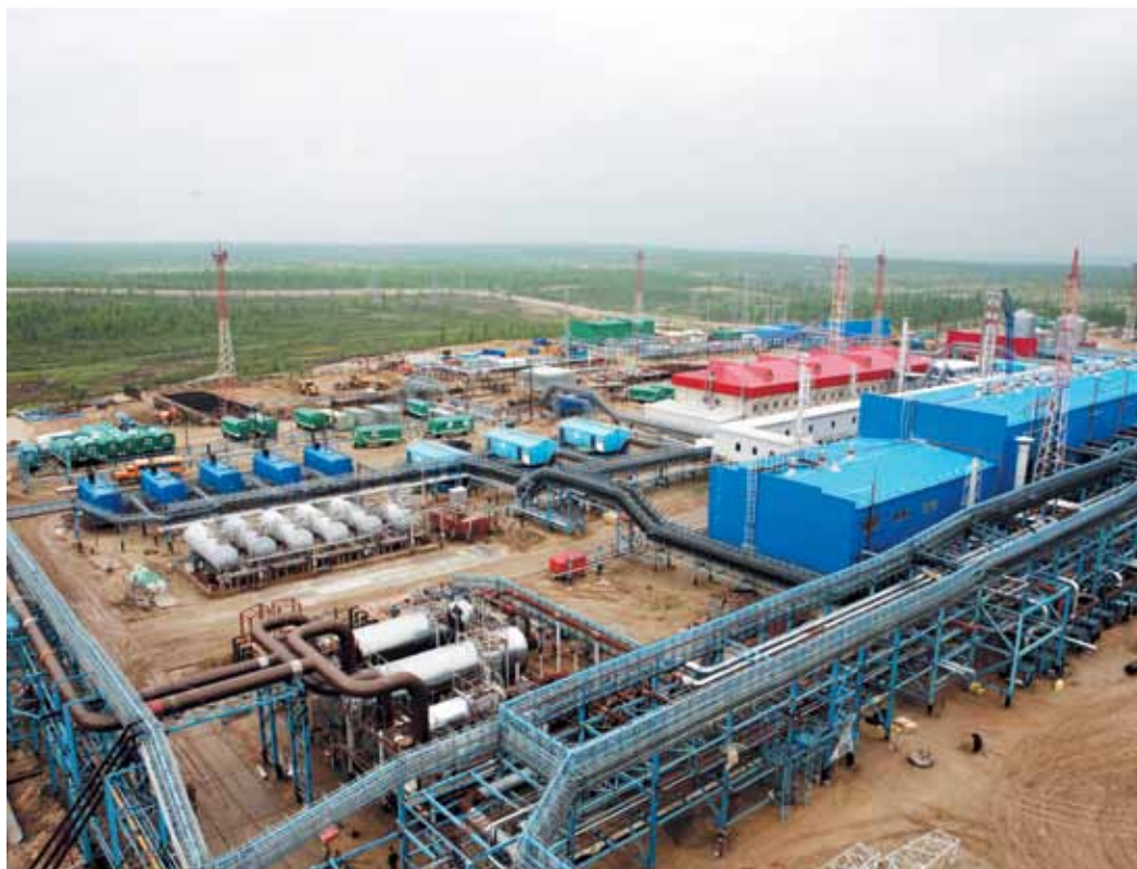
Установка комплексной подготовки газа №2В Заполярного месторождения
