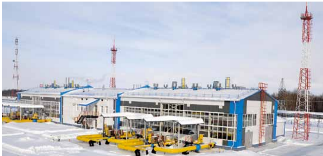
После реконструкции КС «Чажемто» и внешне, и внутренне отличается от предшественницы, проработавшей 30 лет
