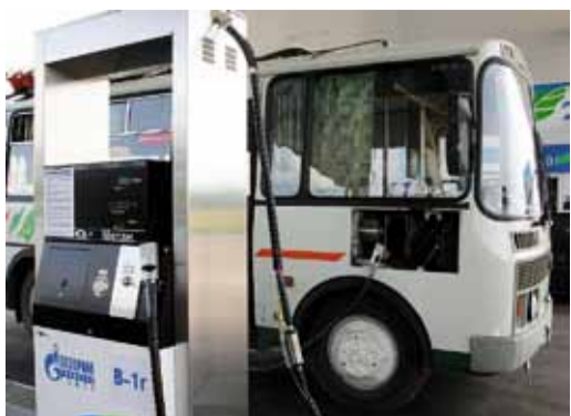
АГНКС в Горно-Алтайске
