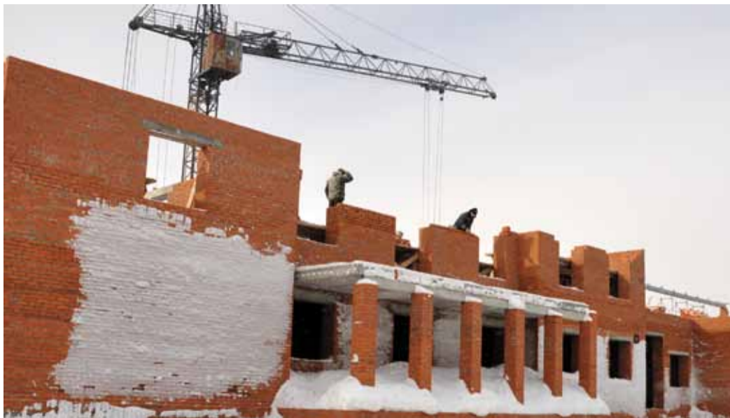
Работы на стройке продолжаются весь световой день
